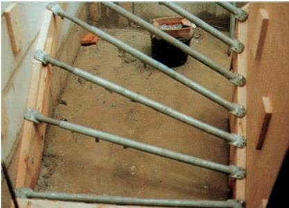
Die Montage der Teleskoprohre erfolgt von unten nach oben
