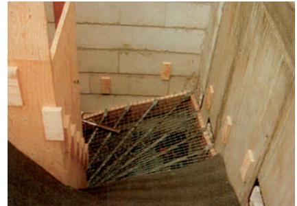
Der Treppenbelag wird auf das Wellengitter aufgelegt und passend abgeschnitten. Die Befestigung erfolgt mit Rödeldraht an den Teleskopstreben
