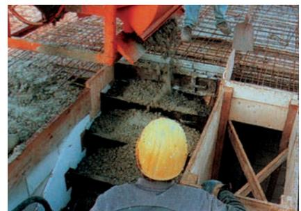
Anschließend wird Beton B25 - 0-16 Körnung mit einem Ausbreitmaß von 35 - 40 cm in die Treppenstufen gegossen
