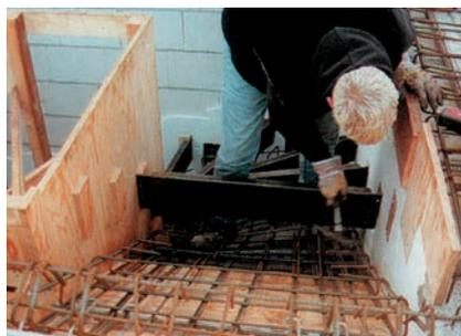
Die ausziehbaren verzinkten Treppenstufen werden mit 65er Nägeln an den Stufenlaschen befestigt
