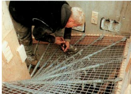
Die flexiblen Wellengitter werden auf die Teleskoprohre gelegt und mit Rödeldraht befestigt
