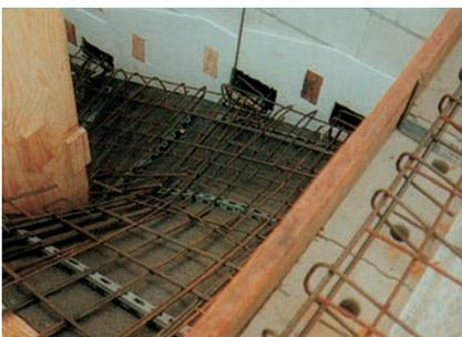
Die Bewehrung bzw. Eisen wird mit entsprechenden Abstandhalter verlegt und befestigt (42 Laufmeter Rundeseisen 8 mm und ca. 8 m<sup>2</sup> Bewehrung Q 131)
